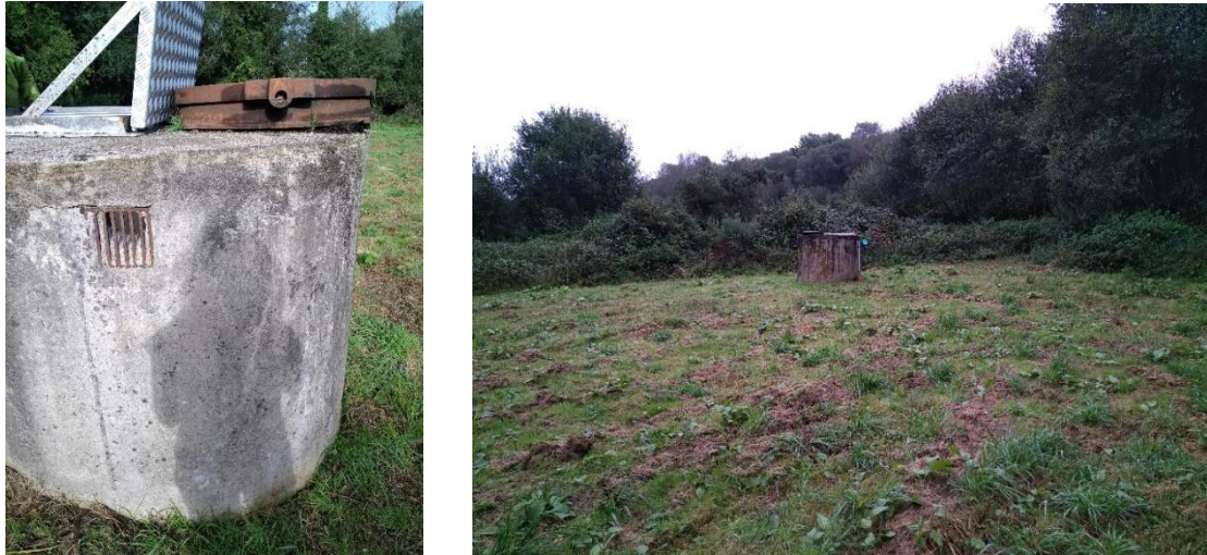
Figure 13 : Captage P1(3) dans son environnement proche
