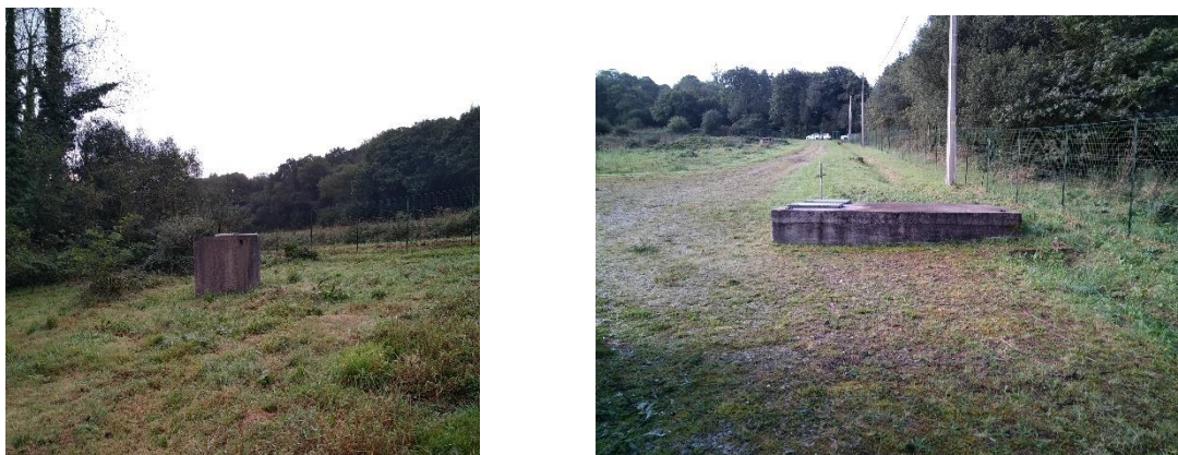
Figure 8 : Puits P4(2) (à droite) et vue depuis le réservoir (à gauche) – boisement en pourtour zone clôturée
