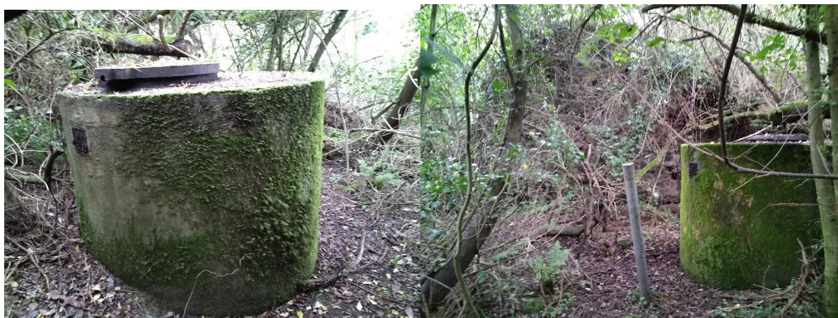
Figure 17 : Captage P2(5) dans son environnement proche
