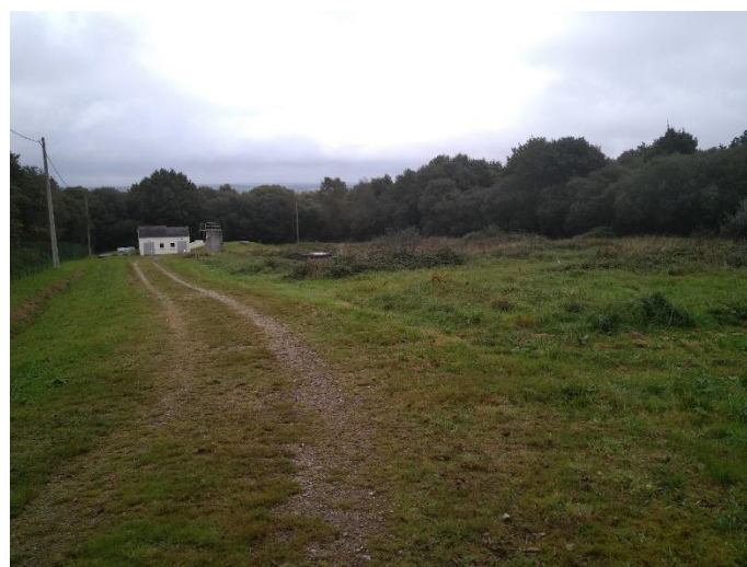
Figure 30 : Photo de la station de traitement au fond, et du puits P5(1) à droite
