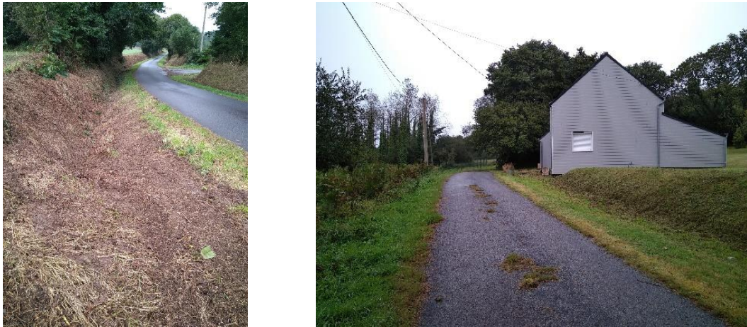
Figure 35 fossé de la route communale photo de gauche – chemin d'accès aux puits photo de droite
