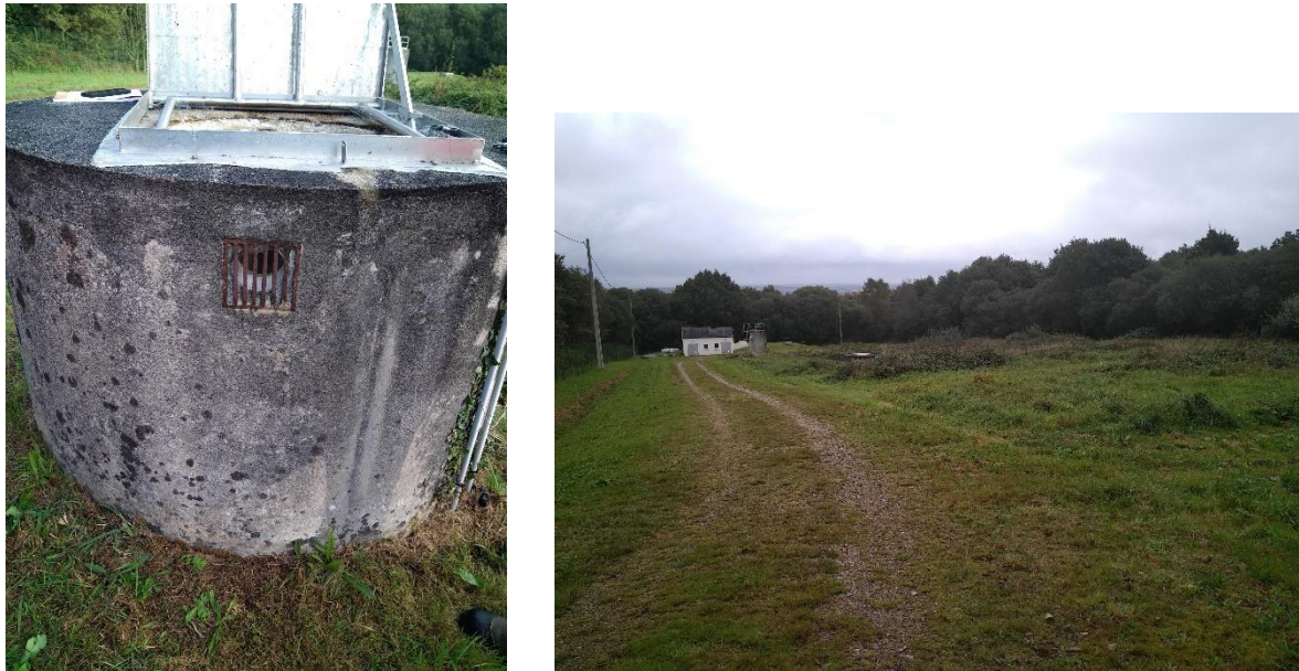
Figure 12 : Captage P5(1) dans son environnement proche
