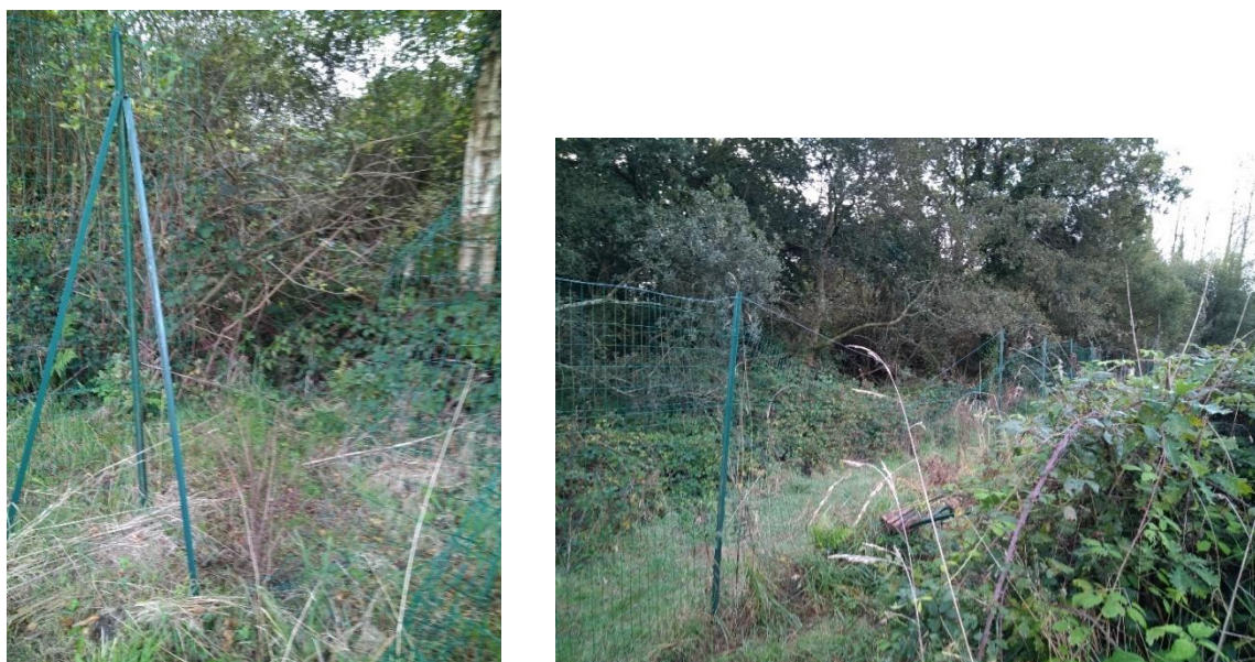
Figure 10 : photo de gauche fossé périphérique – photo de droite : grillage endommagé
