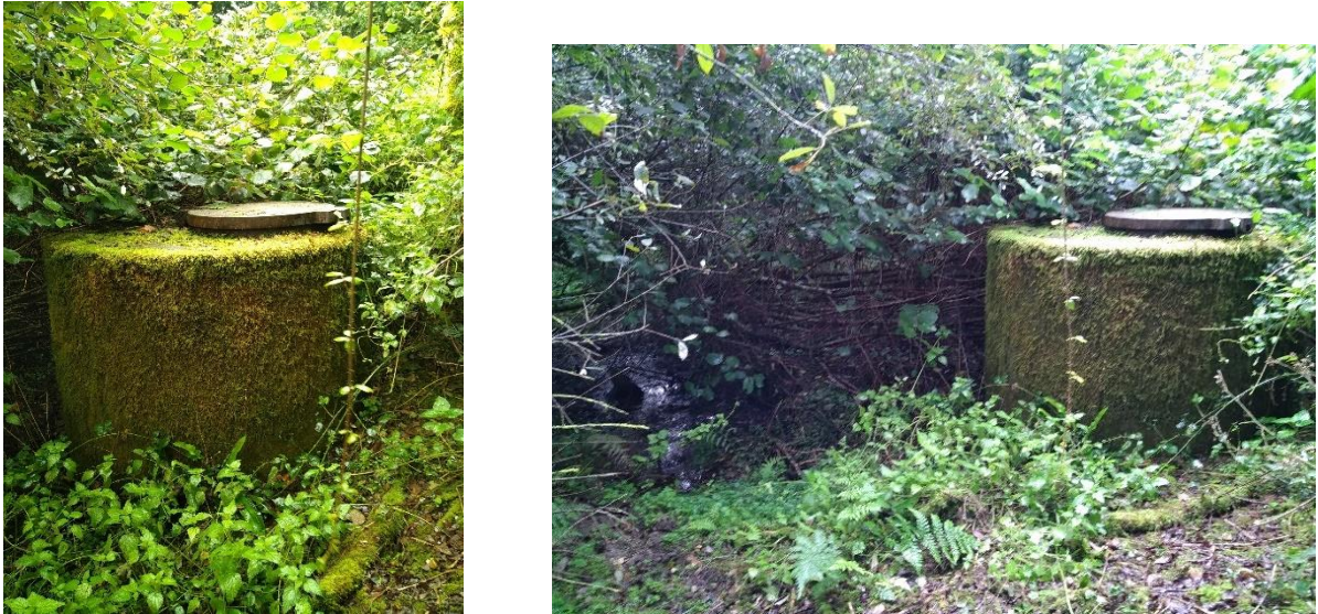
Figure 15 : Captage P3(4) dans son environnement proche
