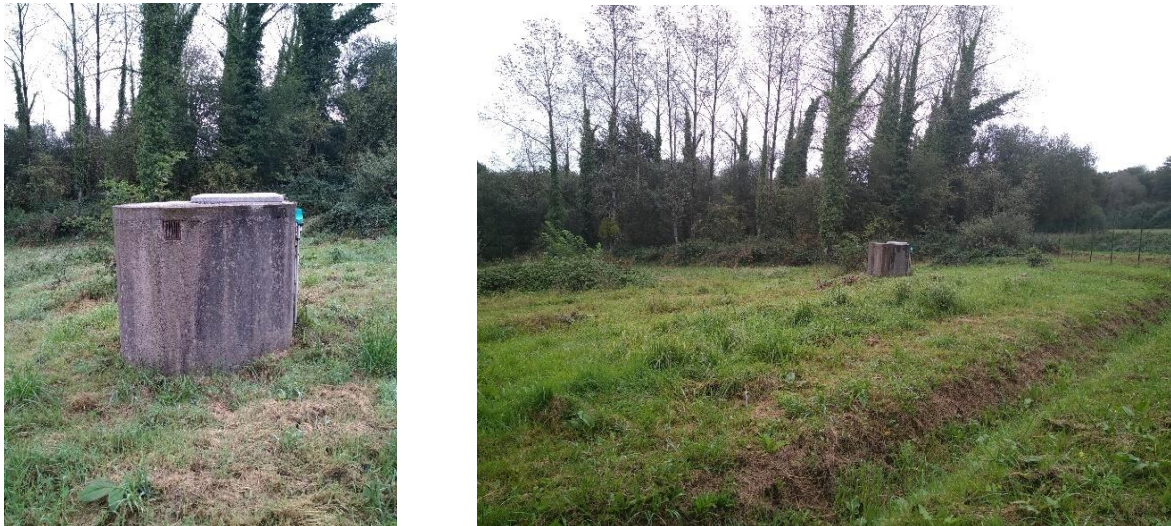
Figure 11 : Captage P4(2) dans son environnement proche
