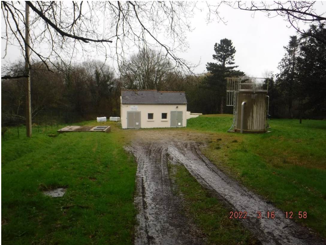
Photo 18 : Installations de traitement
