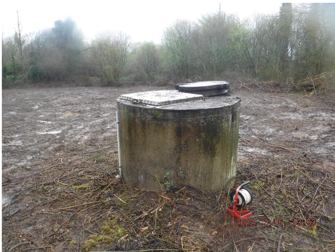
Photo 8 : Puits P1(3) (extérieur)
