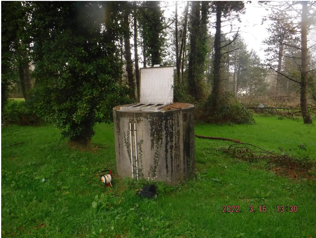
Photo 5 : Puits P4(2) (extérieur)
