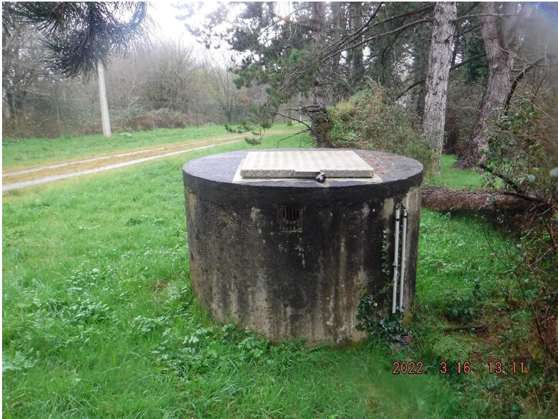
Photo 1 : Puits P5(1) (extérieur)
