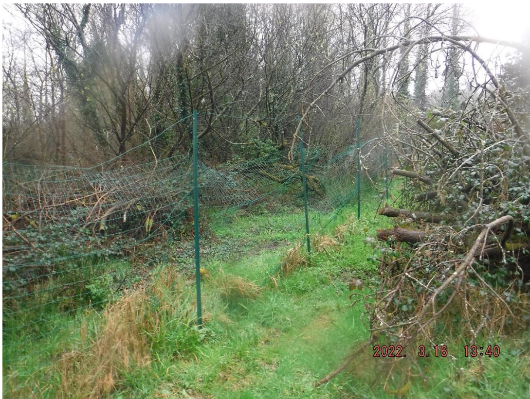
Photo 22 : Clôture est abimée par une chute d'arbre
