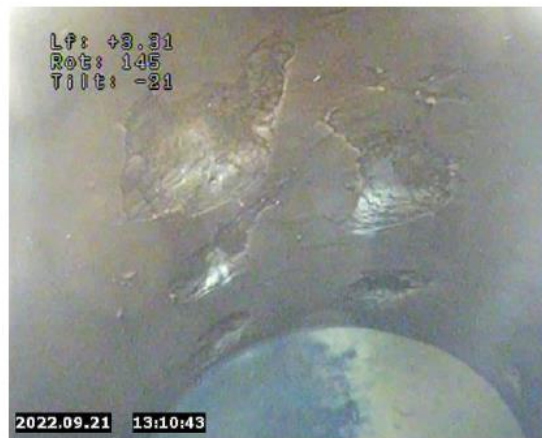
Prof 3.31 m : vision axiale / barbacanes ouvertes / parois avec fins dépôts de fer
