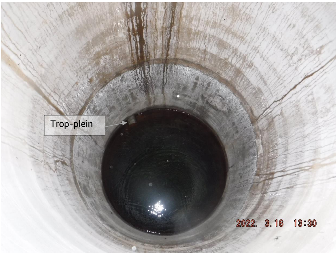
Photo 6 : Puits P4(2) (intérieur)
