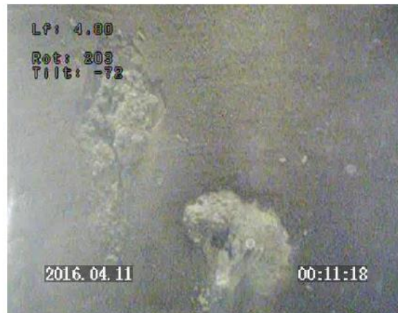
Prof 4.80 m : vue latérale sur des barbacanes présentant des accumulations d'hydroxyde de fer
