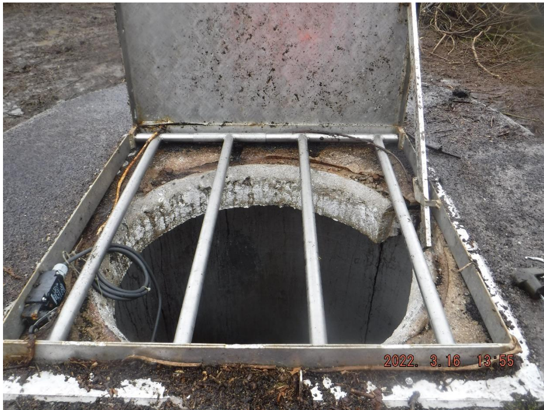
Photo 9 : Puits P1(3) (accès)
