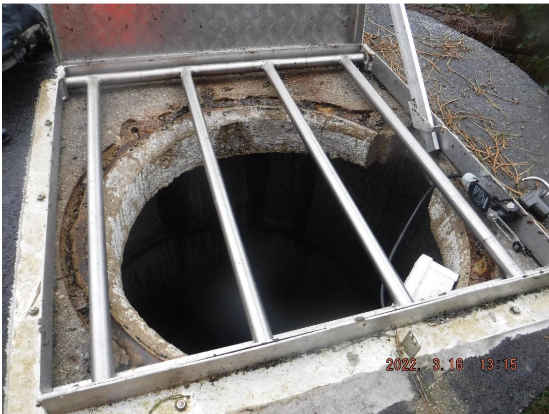
Photo 2 : Puits P5(1) (accès)
