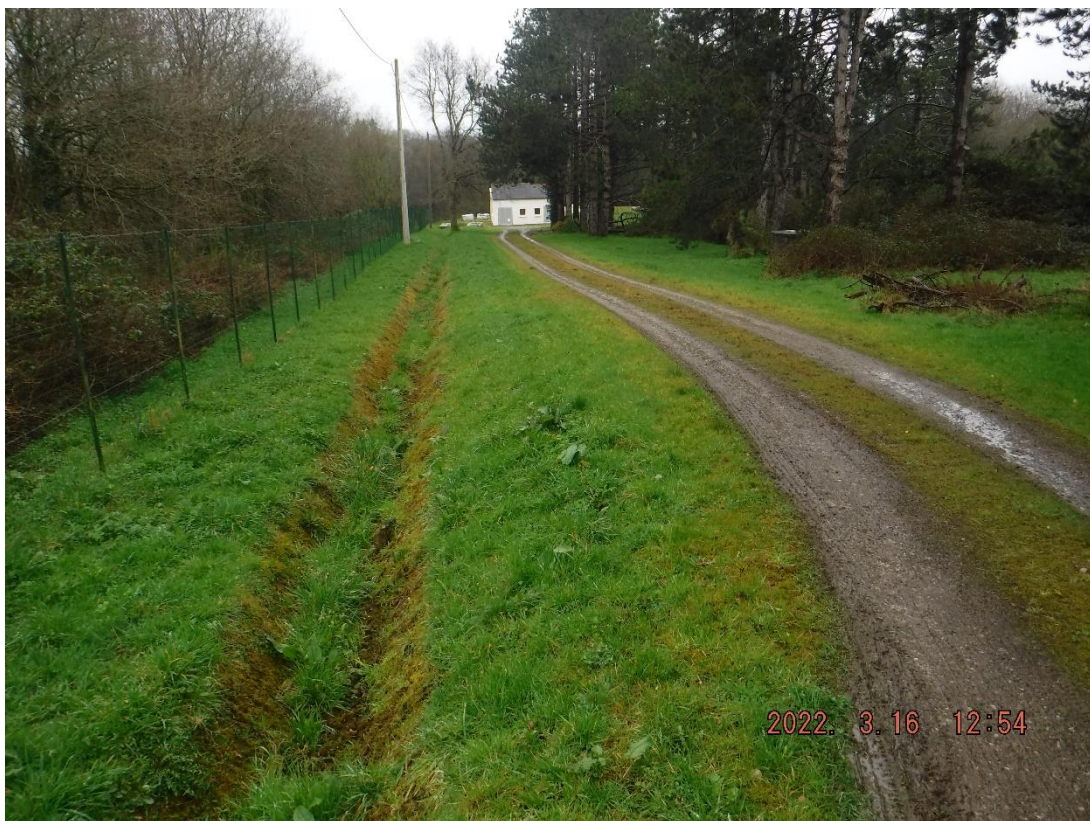
Photo 21 : Chemin d'accès à la station de traitement et fossé périphérique ouest
