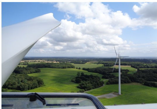
Parc éolien d'Yvignac la Tour
