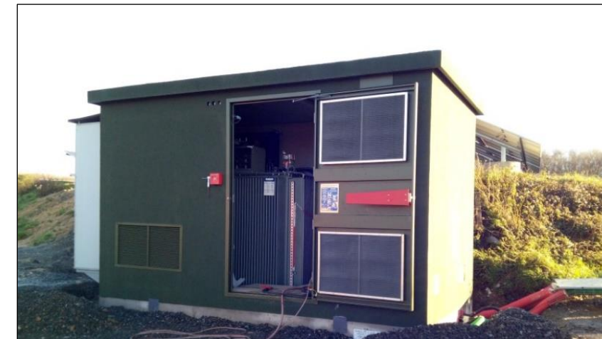
Figure 208: Photo d'un poste de transformation d'un projet en phase de construction (Source : IEL)
