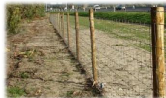
Figure 214 : Exemple de clôture rustique
