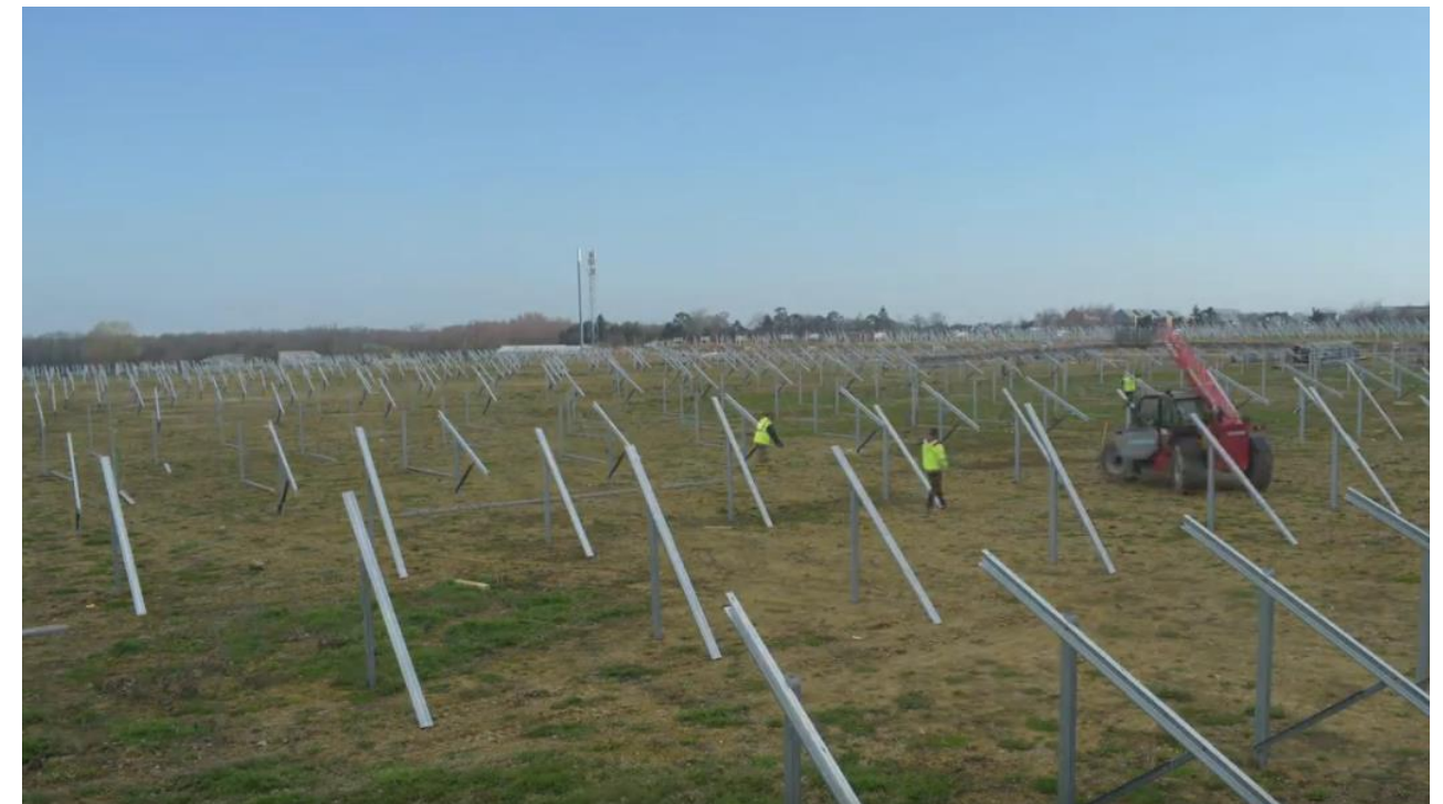
Figure 29 : Assemblage des structures porteuses - photos de la construction de la FS Marc Energies, une réalisation IEL
