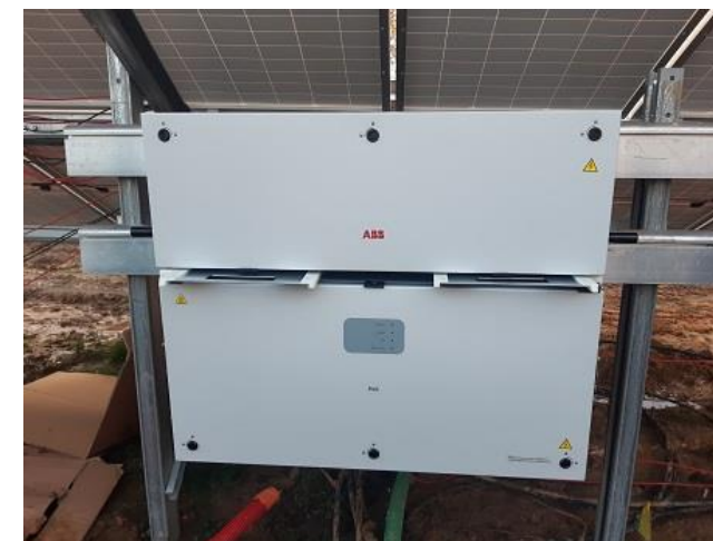
Figure 34 : Onduleurs fixés sur les structures photovoltaïques (FS Beauvoir, photos prises en phase construction, IEL)
