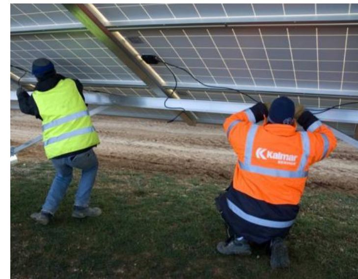
Figure 32 : Câblage des panneaux photovoltaïques
