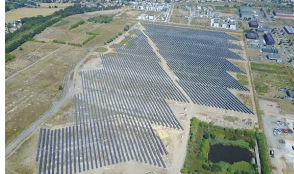
Ferme solaire du Plateau – Colombelles (14) Centrale solaire photovoltaïque de 10 MWc Mise en service : 2018
