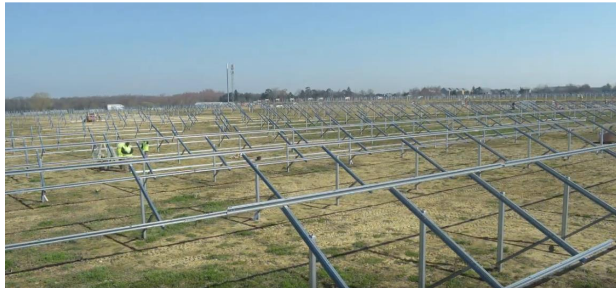
Figure 30 : Assemblage des structures porteuses - photos de la construction de la FS Marc Energies, une réalisation IEL
