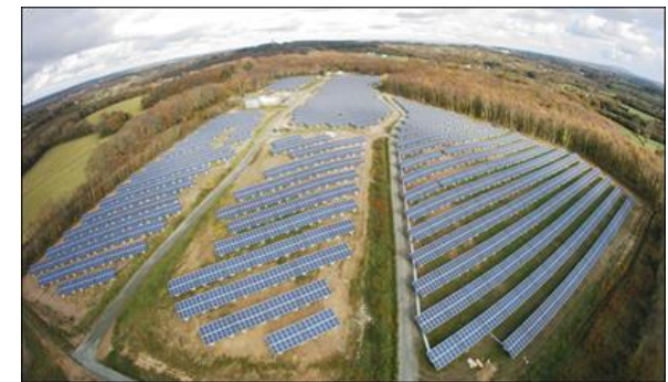
Ferme solaire Le Cosquer – Plounévez-Moëdec (22) Centrale solaire au sol de 2,66 MWc Mise en service : 2021
