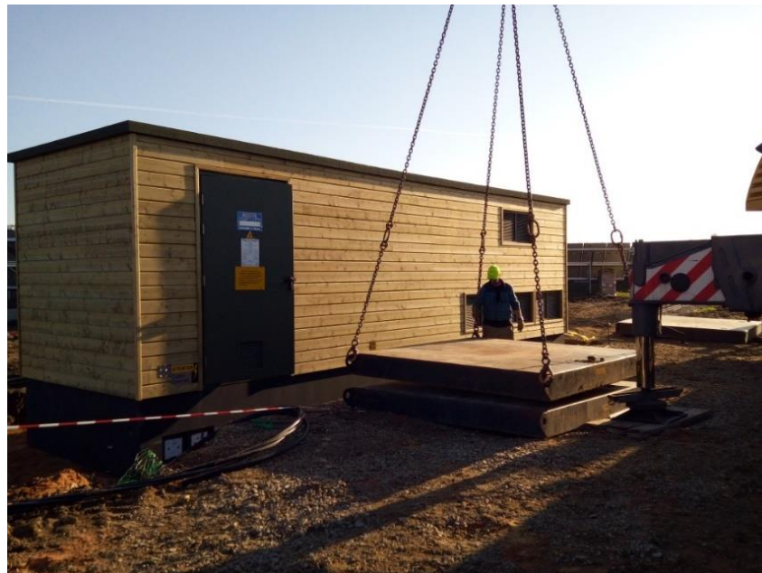
Figure 36 : Poste de livraison avec bardage bois, projet en phase travaux (source : IEL)
